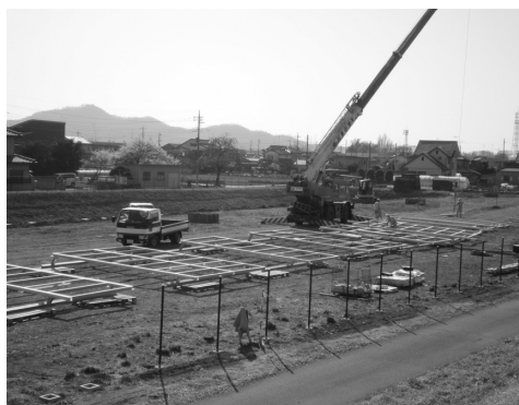
渡良瀬川対岸への太陽光パネル設置工事
